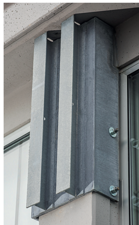
Esempi di sistemi di vincolo installati dall'esterno
