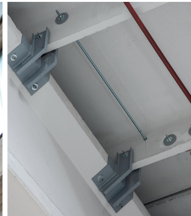
Esempi di sistemi di vincolo tegolo-trave
