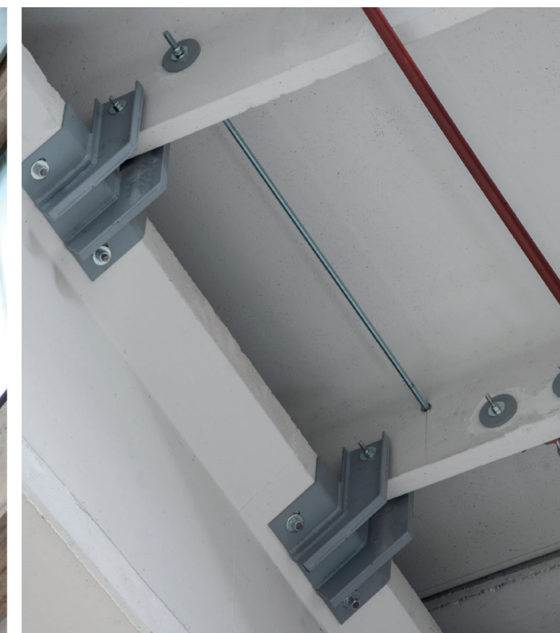
Esempi di sistemi di vincolo tegolo-trave
