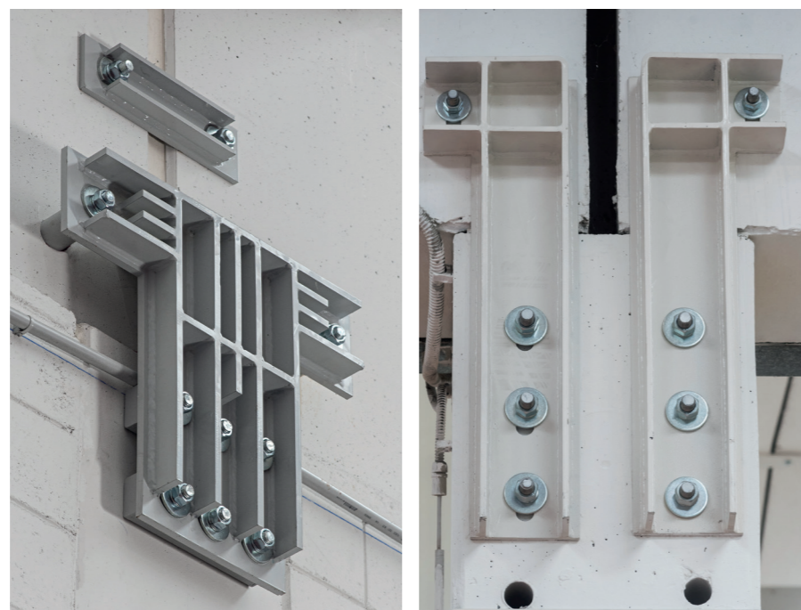
Esempi di sistemi di vincolo trave-pilastro
